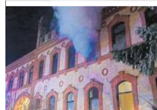
In Bruckneudorf brannte es in einem Zimmer im 1. Stock
