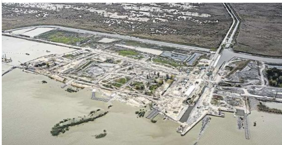
Trotz Protesten wird am ungarischen Seeufer weiter an dem riesigen Tourismusresort gebaut
